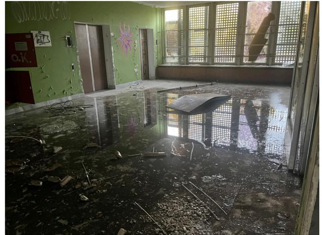
Abbildung 33: Wassereinwirkung Erdgeschoss Haus 701
