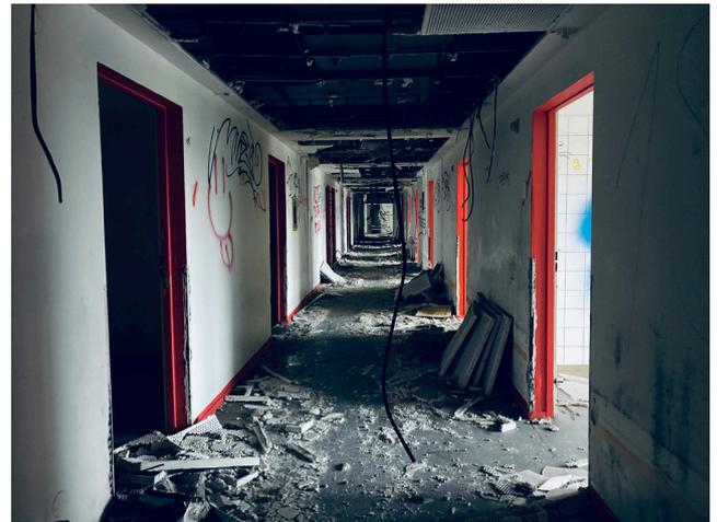
Abbildung 6: Flur im Gebäude mit zerstörten Decken und Wänden, Kabel die aus der Decke hängen (eigene Aufnahme)
