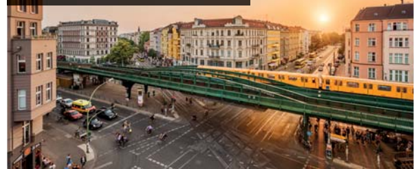
HÖCHBAHN SCHÖNHAUSER ALLEE / EBERSWALDER STRASSE
